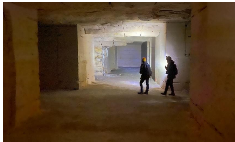
Prospections en carrières souterraines © Q. Rouy
