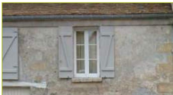
*Façade de moellons calcaires enduits au plâtre et chaînages en pierre de taille*
