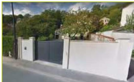
*Auvers-Sur-Oise (avant-après)... Restaurations inadaptées de bâti ancien par des ravalements (produits industriels et mises en œuvre « mécanisées ») qui donnent à des maisons rurales ou bourgeoises et leurs clôtures l'aspect de pavillons neufs, avec tous les effets de modes (enduits lissés et redressés à l'extrême, menuiseries anthracite) qui effacent complètement les spécificités architecturales et paysagères locales.*
