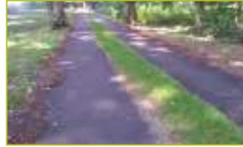
*Il est possible d'améliorer le confort de roulement des chemins en préservant leur gabarit traditionnel (profil en travers composé de deux bandes de roulement, avec bandes enherbées de part et d'autre et au centre).*
