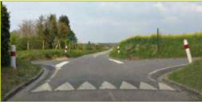
*Aménagement de sécurité en entrée de village : le plateau surélevé et le « pincement symétrique » sont les aménagements les plus discrets, à recommander dans le Vexin*
