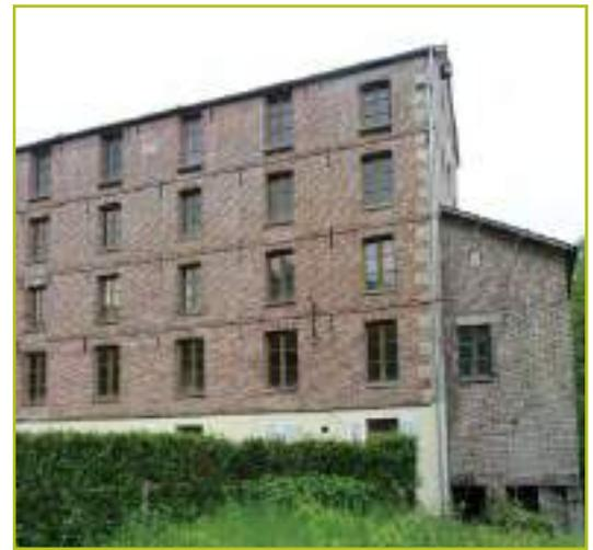
Comme dans les unités voisines de l'ouest du Vexin, le calcaire est majoritairement présent sous forme de plaquettes ou blocs parallélépipédiques réguliers, à joints minces pour les bâtiments, ou à pierre sèche pour les murs de clôture. Les mortiers et enduits les plus anciens sont à la chaux et au sablon de couleur ocre-jaune.
