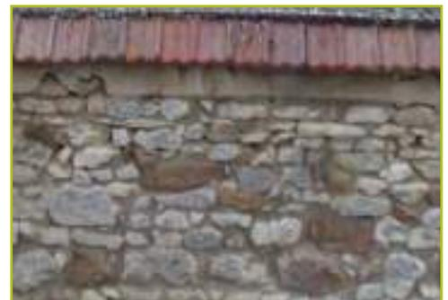
*Moellons calcaires irréguliers, parfois mélangés de grès, harpags en pierre de taille, enduits au plâtre, joints à la chaux, couvertures en tuiles plates ou mécaniques (Gadancourt)*
