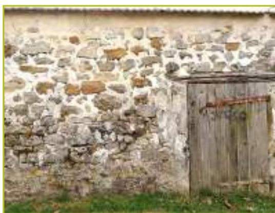
*A l'Est du Vexin, usage de moellons de calcaire coquiller (reflets blonds) aux formes plus grossières, sans arêtes marquées, à droite mélange de calcaire et grès et joints au plâtre (Us).*
