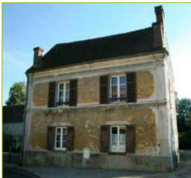
*Moellons calcaires aux joints largement beurrés, à gauche au mortier chaux-sable foncé, à droite au plâtre paysan.
