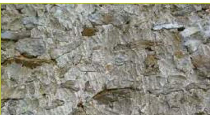
*Mur de calcaire et meulière jointoyé au plâtre (traces de doigts)*
