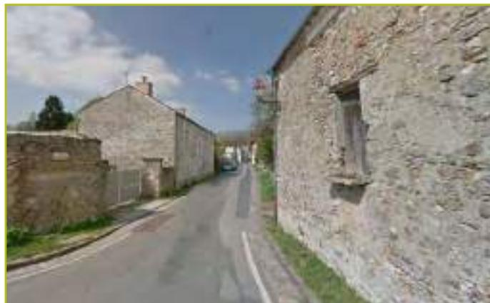
*Dominante de calcaire lutétien (de taille ou en moellons), quelques grès, joints ou enduits à la chaux, et dans une moindre proportion, en plâtre (Frémainville)*
